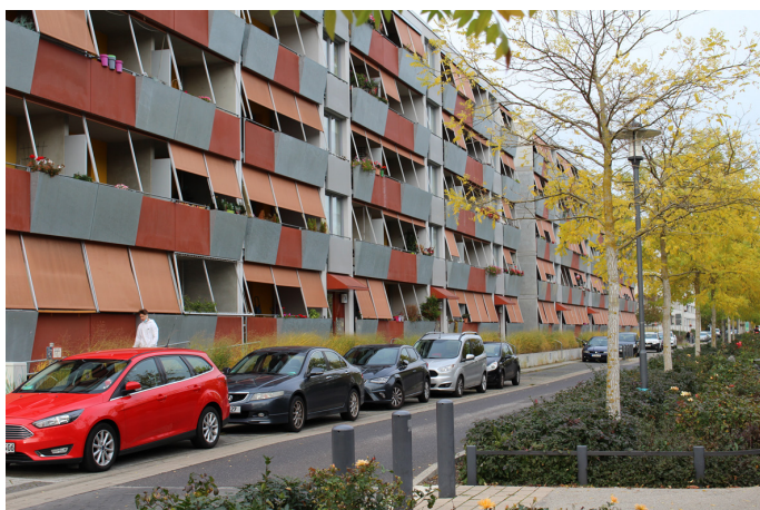
Fot. 28. Zmodernizowana fasada bloku mieszkalnego Źródło: Instytut Rozwoju Miast i Regionów.
