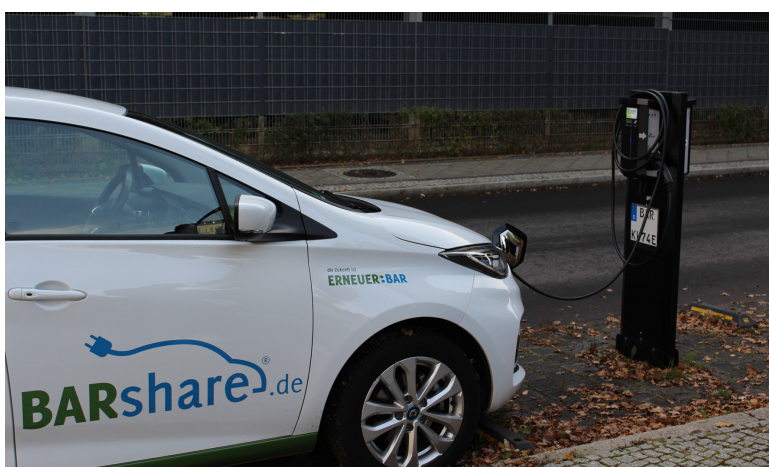
Fot. 4. Stacja ładowania elektrycznego z możliwością zwrotu energii elektrycznej do miejskich zasobów komunalnych Źródło: Instytut Rozwoju Miast i Regionów.
